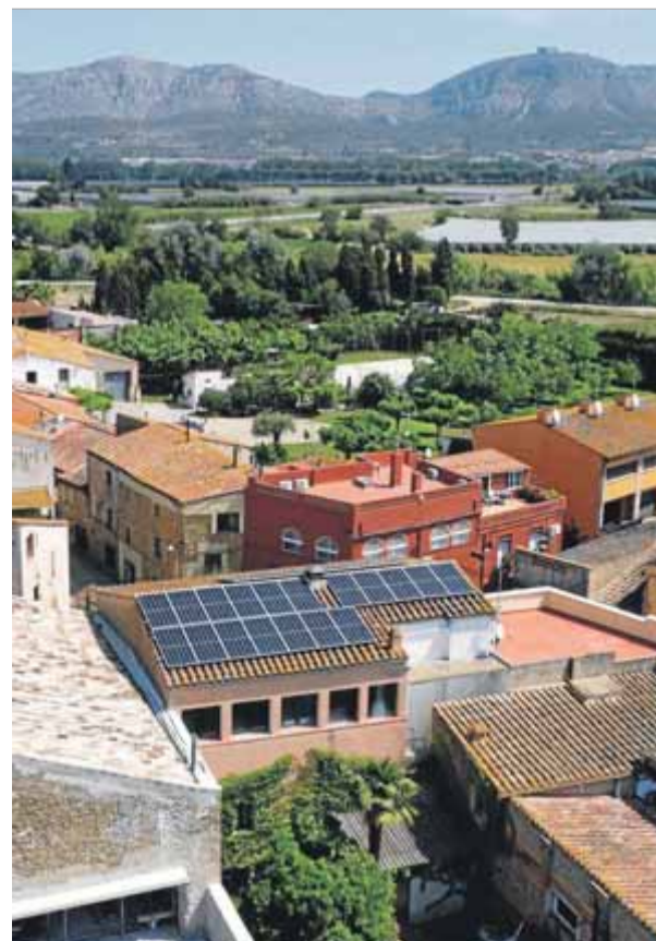
Plaques fotovoltaïques a Gualta ■ DIPUTACIÓ DE GIRONA
